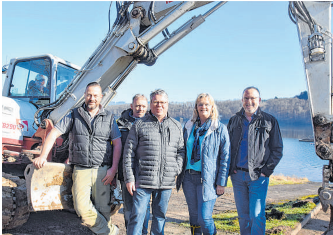
An der Erneuerung der Hafenanlage beteiligt: Oliver Lippe (Hafenmeister), der Bauleiter der beauftragten Firma Schmidt, Peter Enders (Vorsitzender), sowie die WSVB-Mitglieder Sabine Kantelhardt und Stefan Färber (von links). FOTO: KRAUSE
